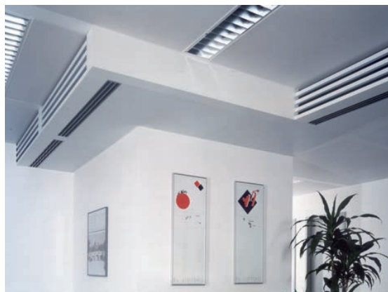
Einbaubeispiel LTG System Indivent
